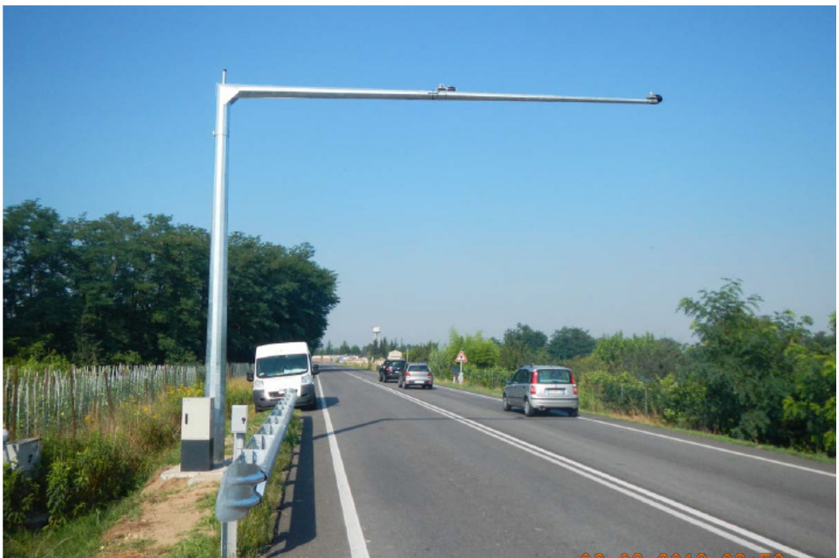
Figura 2: Postazione di rilevamento traffico TOC con ritto, sbraccio e alimentazione elettrica.
