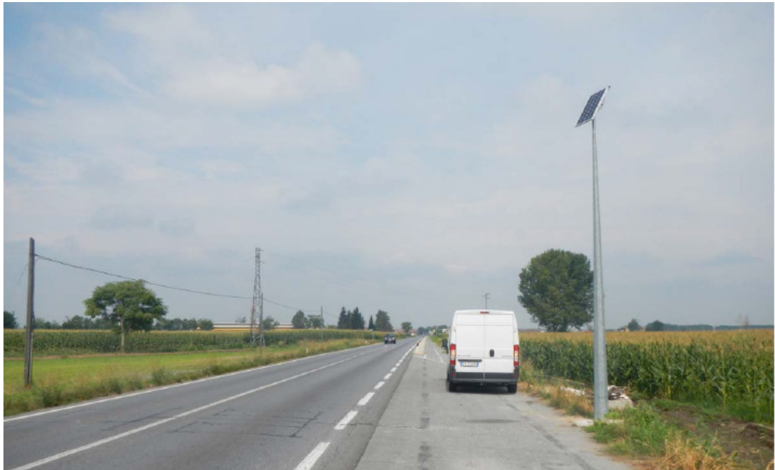
Figura 3: Postazione di rilevamento traffico TOC con solo ritto e alimentazione da pannello solare
