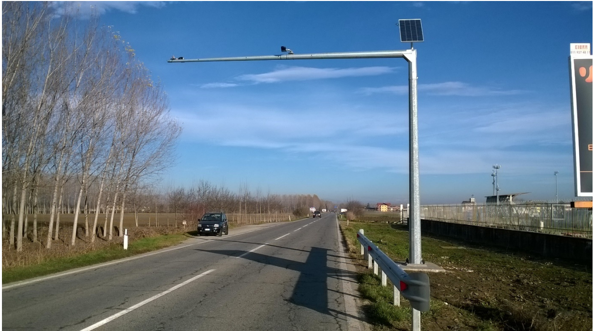
Figura 1: Postazione di rilevamento traffico TOC con ritto, sbraccio e alimentazione da pannello solare.
