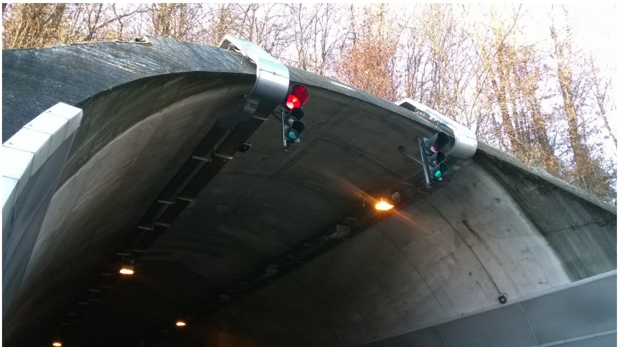
Figura 6: Postazione di rilevamento traffico TOC (BI-03) con sensoristica di rilevamento posizionata nel soffitto della galleria.
