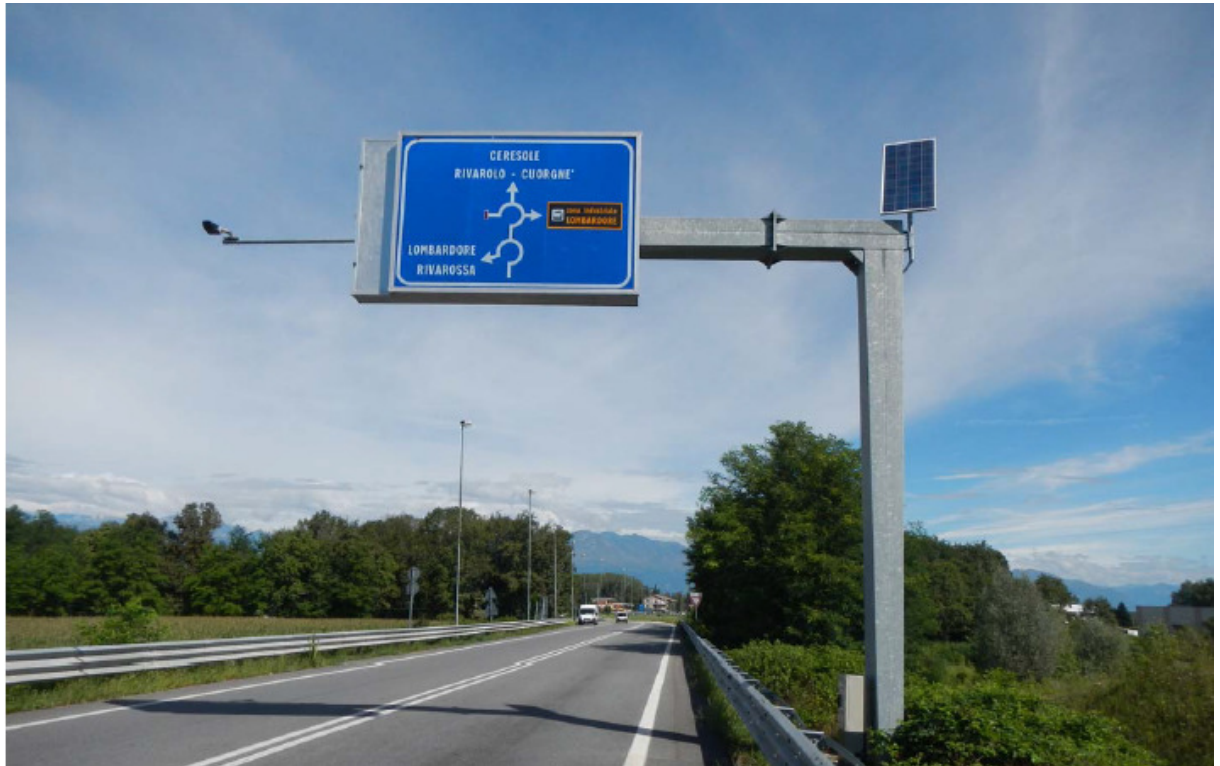
Figura 5: Postazione di rilevamento traffico TOC (TO-13) con braccio e pannello solare installato su una infrastruttura della provincia di Torino.
